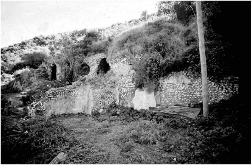
Fig. 3 - Panoramica del pendio con le strutture coperte dalla fitta vegetazione.
