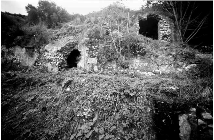
Fig. 9 - Gradola: panoramica delle cisterne poste sul lato occidentale.
